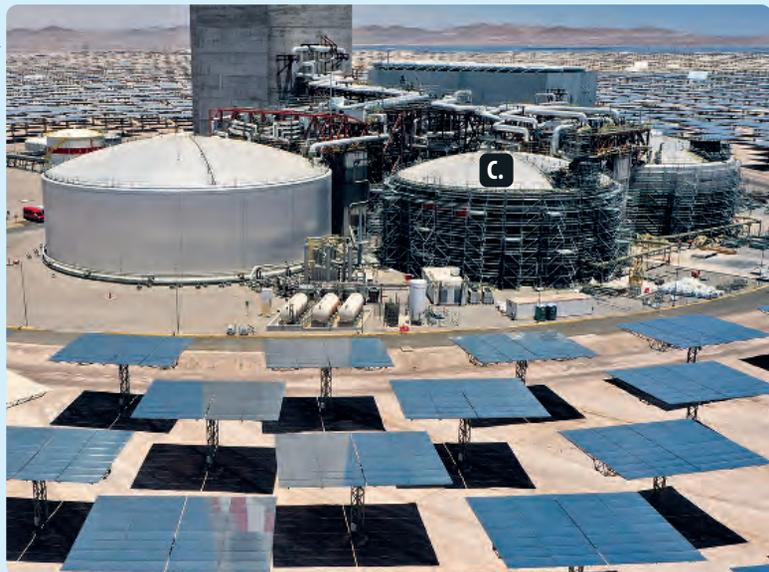
**C** Existem também as chamadas usinas heliotérmicas, que utilizam o calor do Sol para aquecer a água, transformando-a em vapor capaz de girar uma turbina, que, por sua vez, também gera energia elétrica.
